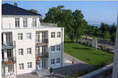
Hausansicht "Villa Aquamarina" von der Südseite (Nachbarhaus)
