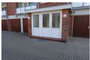
Der Eingang des Hauses mit einer Stufe
