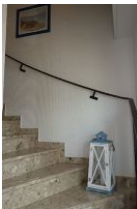
Das Treppenhaus führt zu beiden Wohnungen
