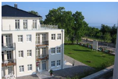
Hausansicht "Villa Aquamarina" von der Südseite
