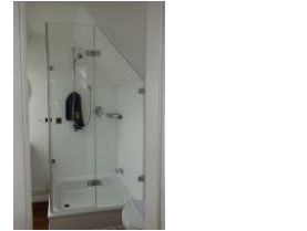
Das kleine Duschbad im Dachgeschoß mit neuer Duschkabine....
