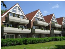
Die rückwärtige Ansicht des Hauses Olhörnweg 1 Die Balkone sind versetzt gebaut, so stört kein Gast den Anderen.
