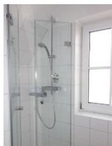
...Dusche, neu mit Glastür.
