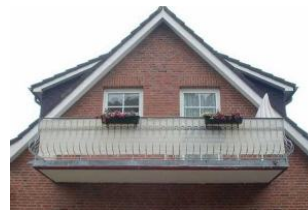
Der Balkon von außen
