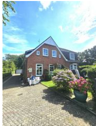
Das Haus von außen
