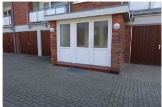
Der Eingang des Hauses mit einer Stufe
