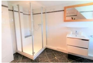
Das moderne Duschbad mit Dusche, Waschtisch und WC.
